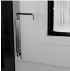
Wenn der Flügel unten an den Beschlagteilen streift, ist das Hochstellen des Flügels notwendig. Abdeckkappe heruntergeben!
