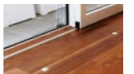
Laufschiene dezent im Fußboden eingelegt.
