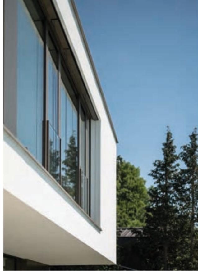
ALWOOD und ALEVO bestehen durch minimalistischem Flügel und nahezu Bündigkeit von Rahmen, Flügel und Glas gerade auch in Kombination mit Fixverglasungen.
